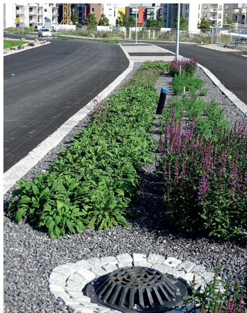
Foto. Pilkupüüdva haljastusega vihmapeenar immutab sõiduteelt sinna valguva sademevee Turu linnas. ©Turu linn.
